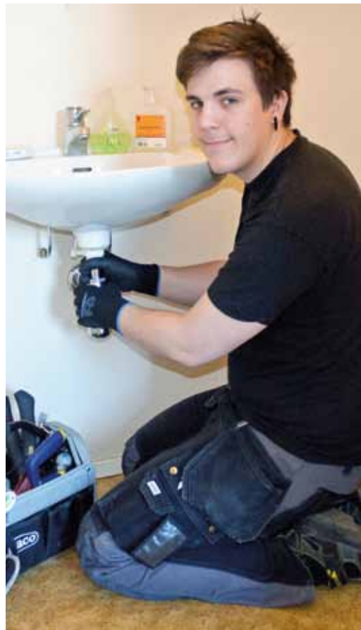
Ville Byberg är en av fastighetsskötarna som arbetar med Kungälvbostädernas fastigheter.
